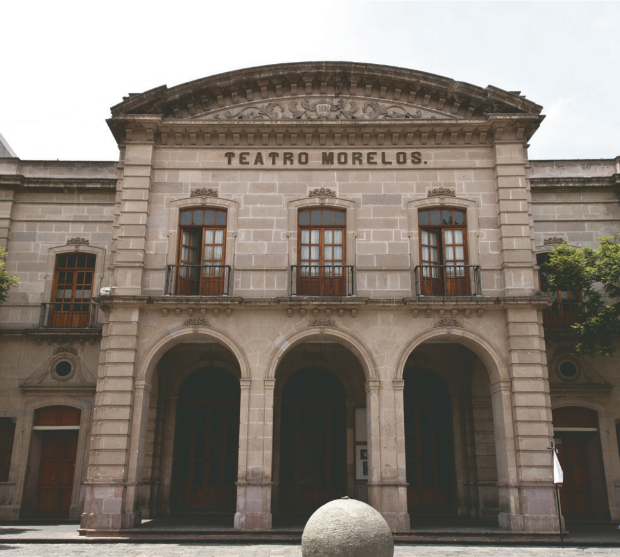
Figura 28. El Teatro Morelos forma parte del patrimonio arquitectónico local y nacional.
