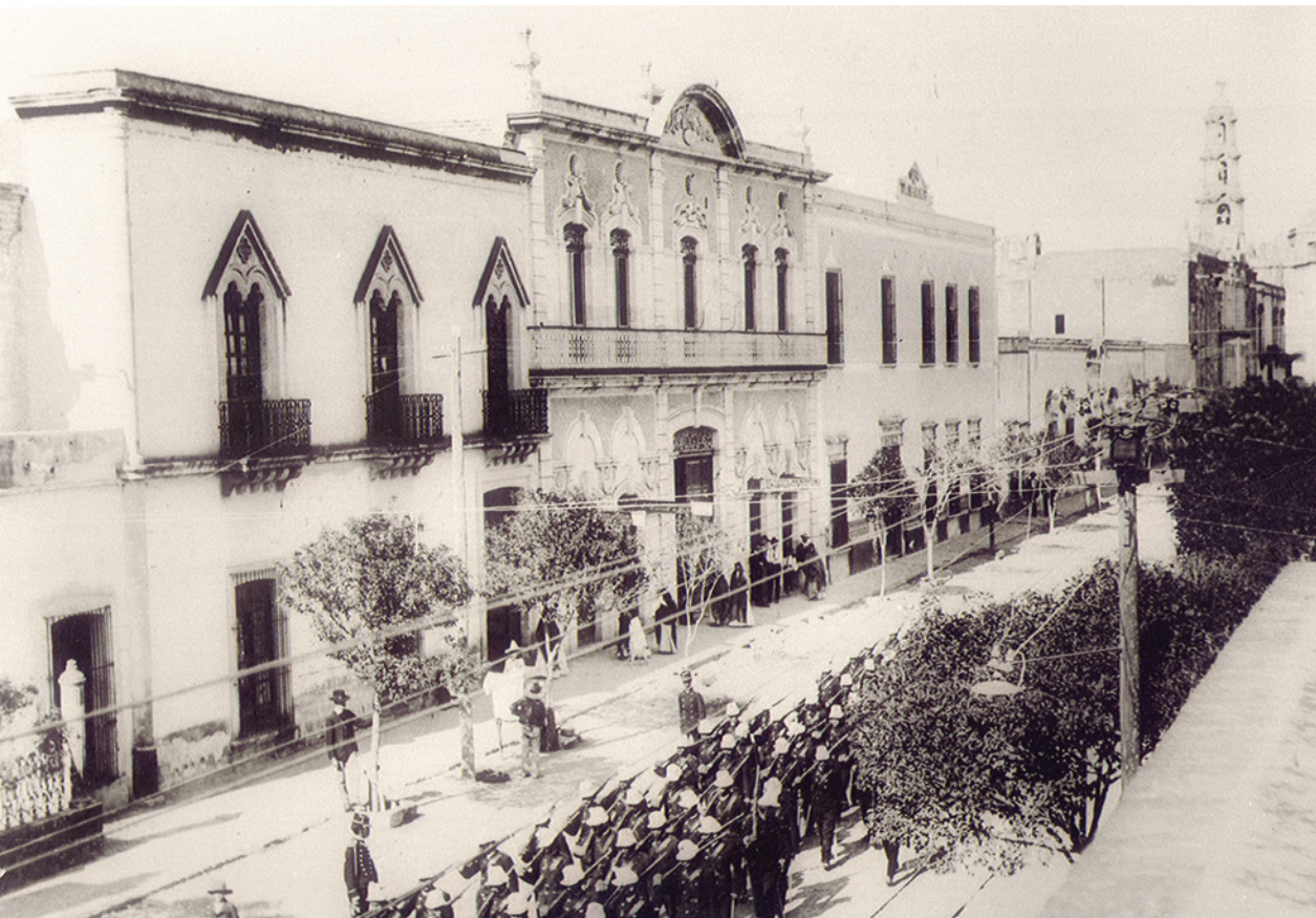
Figura 24. La demolición de los dos edificios (al centro y a la izquierda) se considera como una pérdida de patrimonio en Aguascalientes y por consecuencia una pérdida de identidad cultural. Fuente: AHEA, Fondo CIRA, pág. 35, Fot. 138.
