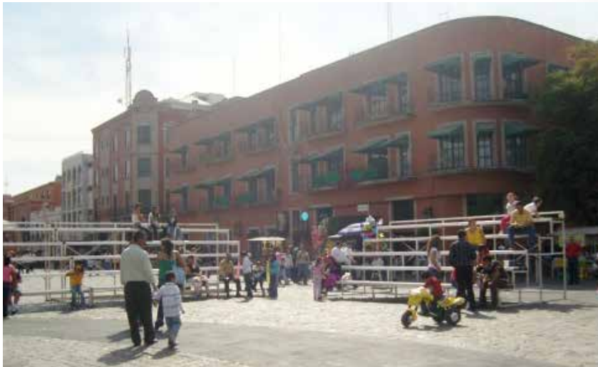
Figura 8. Vista del edificio de Relaciones Exteriores en el año 2009. Fuente: Fotografía Fondo EGDVR, 2009.
