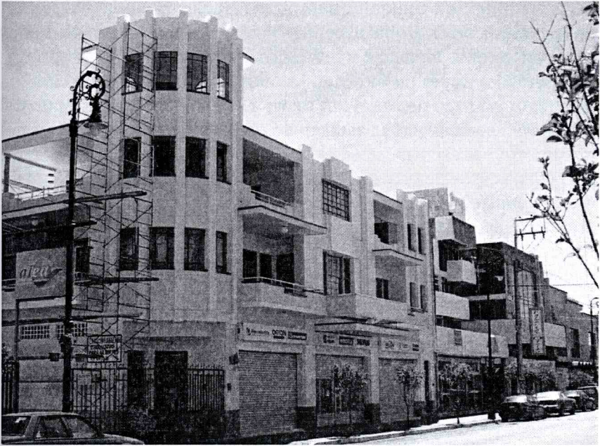
Figura 4 - Una casa en la Av. Madero, después de los trabajos de restauración.
