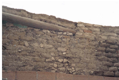
Figura 3. Vista de los principales materiales usados en la construcción típica del poblado de Charcas
