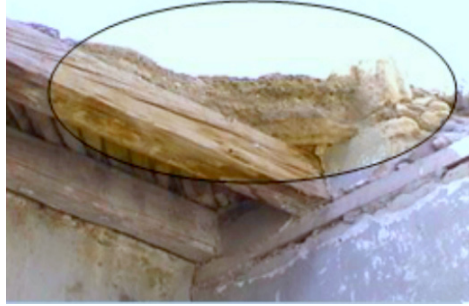
Figura 13. Vista de techumbre de tejamanil
