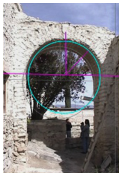
Figura 12. Vista de arco de medio punto de adobe rematado con una clave de piedra caliza Fuente: fotografía propiedad del autor.
