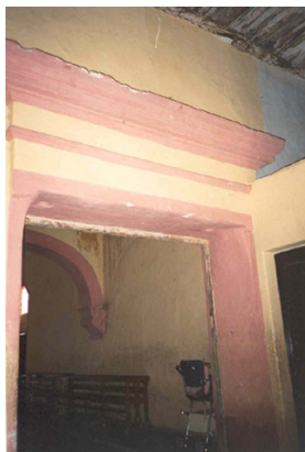
Figura 5. Vista del Portal de Peregrinos del ex convento franciscano Nota: obsérvese la rusticidad de la técnica de construcción de sus remates. Fuente: fotografía propiedad del autor.
