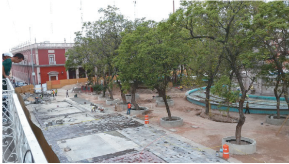
Figura 9. Proceso de los trabajos del nuevo rostro de la Plaza Patria o Plaza Principal de Aguascalientes. Fuente: fotografías Emma G. G. de V., 2014.
