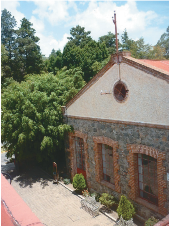
Figura 6. Fachada del cuarto de turbinas. Año: 2013. Autor: Alejandra García Sánchez.
