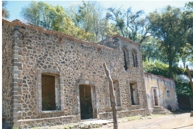
Figura 3. Hidroeléctrica de San Pedro. Año: 2013. Autor: Alejandra García Sánchez.
