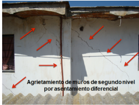
Imagen 9. Daños en planta alta.
