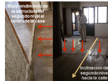
Imagen 7. Desnivel en planta alta.
