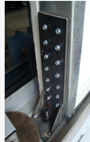
Imagen 2. Anclaje tipo hold-down .
