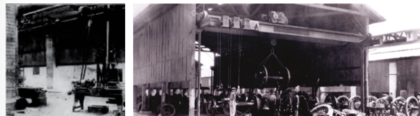
Figura 6. Izquierda: Taller Mecánico del Taller de Locomotoras, 1904. Derecha: Taller de Ruedas, subdepartamento del Taller de Locomotoras, el cual puede verse en el extremo derecho, 1926. En ambas se aprecia el fijo metálico colocado de las fachadas oriente y poniente que caracterizó a buena parte de los edificios del complejo, así como la ausencia de puertas y ventanas de ambos talleres. Fuente: American Engineer and Railroad Journal , mayo 1904: 182 y CEDIF, Fondo Comisión de Avalúo e Inventario-Aguascalientes.
