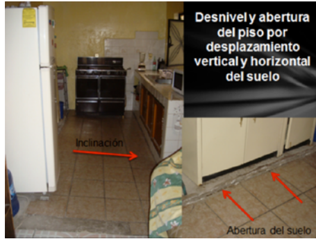
Imagen 9. Daños en planta alta.
