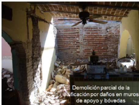
Imagen 11. Demolición parcial de vivienda.
