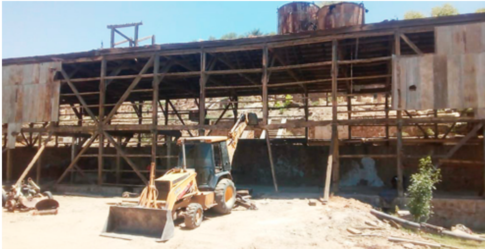
Fig. 4.- Fotografía realizada durante el proceso de la intervención de la bodega El Salvaje en 2018, Fuente: Secretaría de Obras Públicas Municipales de Hgo. Del Parral.
