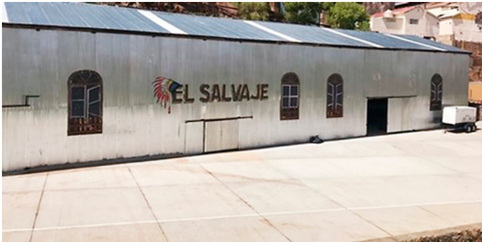
7.- Vista Exterior del Edificio después de su intervención. Fuente: El Monitor de Parral.
