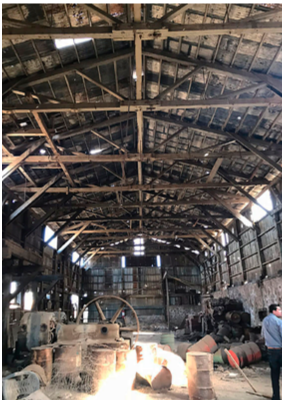
Fig. 3.- Fotografía de la bodega denominada El Salvaje, en el complejo minero La Prieta en Hidalgo del Parral, antes de su intervención, año 2017. Fuente: foto de Alberto Camarena Arellanes.
