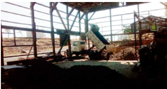
Fig. 5.- Fotografía realizada durante el proceso de la intervención de la bodega El Salvaje, año 2018, Fuente: Secretaría de Obras Públicas Municipales de Hgo. Del Parral.
