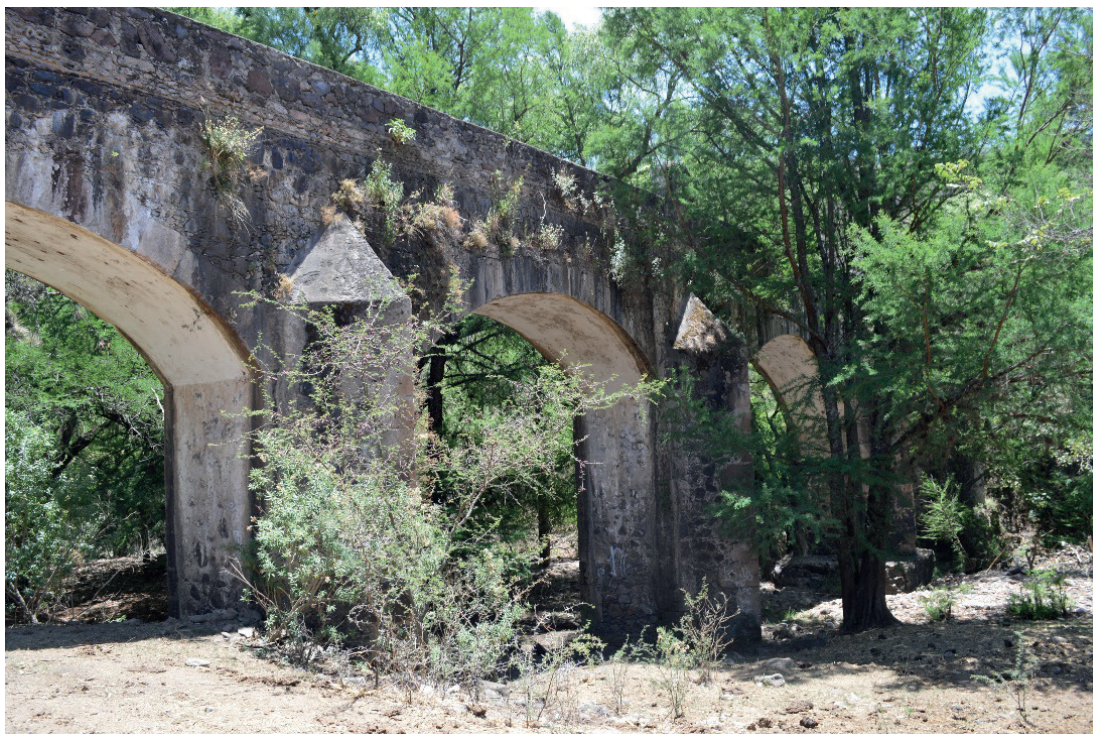
Ilustración 1: Acueducto Las Musas, perteneciente a la antigua hacienda de Atotonilquillo, municipio de Manuel Doblado, Gto. Fuente: MENR.
