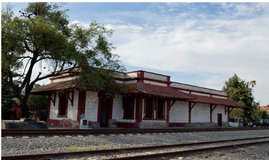
Ilustración 3: Estación de Corralejo actualmente. Fuente: M.EN.R.
