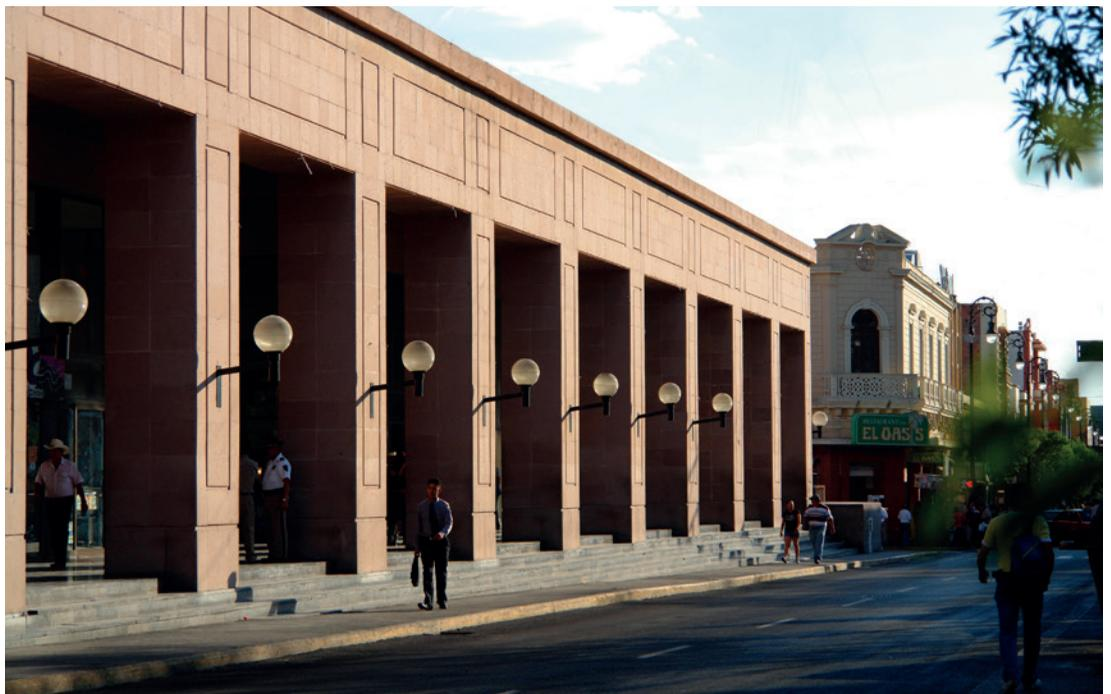
Fotografía 94. En la versión actual de El PARIÁN se utilizó chapa laminada de piedra de cantera para recubrir los elementos estructurales de concreto armado. Fotografía: AAC, 21 de mayo de 2001.
