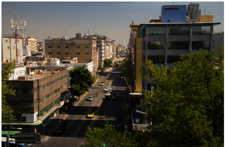
Figura 1. Avenida 16 de Septiembre, un paisaje urbano alterado a partir de la demolición sistemática del patrimonio cultural edificado. Centro histórico de Guadalajara, Estado de Jalisco. Fuente: Pablo Vázquez Piombo, 2017.
