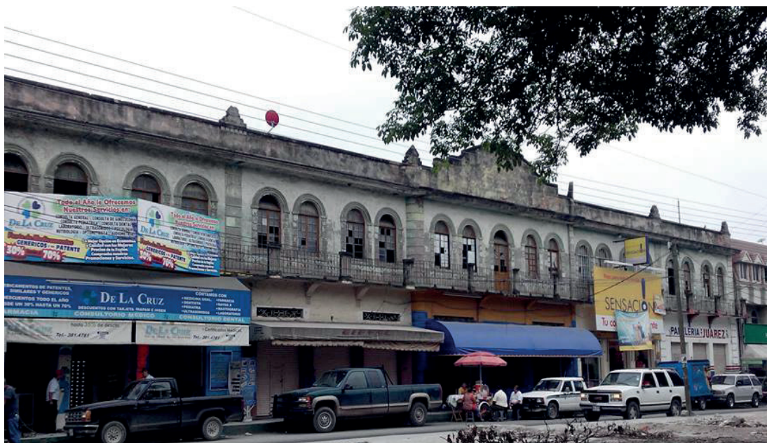
Fig. 22. Edificio Altamirano. 1940. Subdividido en su planta baja, muestra fehaciente de la existencia de edificios relevantes que pasan desapercibidos en la imagen del paisaje y que en 2017 se encuentra en franco deterioro. Fuente: Archivo Luis Bárcenas.
