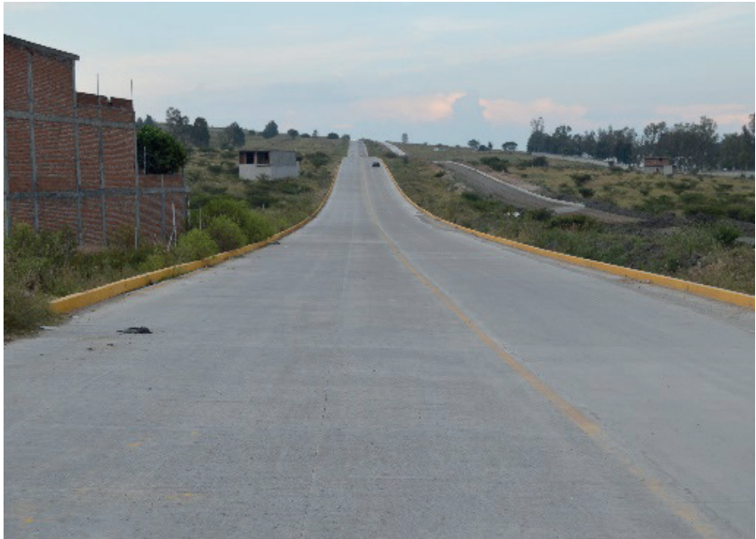
Fig. 20. Carretera de acceso al fraccionamiento Villa Natura. MCHB.
