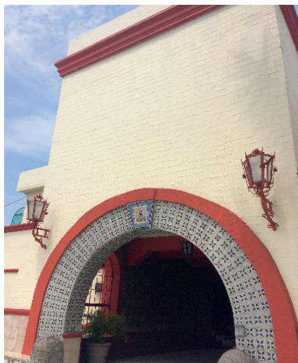
Fig. 18. Hotel Casa Grande transformado hoy en Hotel Misión, persistencia del arco de acceso, ventanas superiores tapiadas y repellado texturizado. Fuente: Alejandra Martínez, Julio de 2017.
