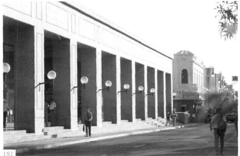
El proyecto incluyó la construcción de un edificio con tres sótanos de estacionamiento y locales comerciales en la parte superior. Se pretendía retomar el concepto de los vanos de los arcos por medio de un pórtico con huecos rectangulares en las cuatro caras del edificio. Se instalaron escaleras eléctricas, aire acondicionado, elevadores y grandes vitrales en el área comercial, pretensiones que no podían ser alcanzadas si se dejaba la construcción anterior.
